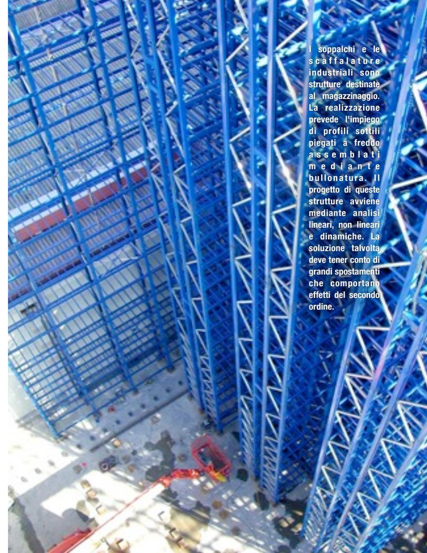
Le scaffalature industriali sono strutture destinate al magazzino. La realizzazione prevede l'impiego di profili sottili piegati a freddo assemblati mediante bullonatura. Il progetto di queste strutture avviene mediante analisi lineari, non lineari e dinamiche. La soluzione talvolta deve tener conto di grandi spostamenti che comportano effetti del secondo ordine.
