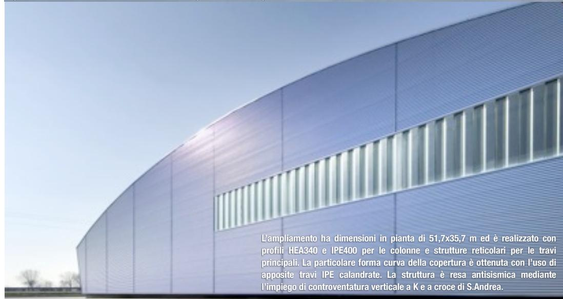
L'ampliamento ha dimensioni in pianta di 51,7x35,7 m ed è realizzato con profili HEA340 e IPE400 per le colonne e strutture reticolari per le travi principali. La particolare forma curva della copertura è ottenuta con l'uso di apposite travi IPE calandrate. La struttura è resa antisismica mediante l'impiego di controventatura verticale a K e a croce di S.Andrea.
