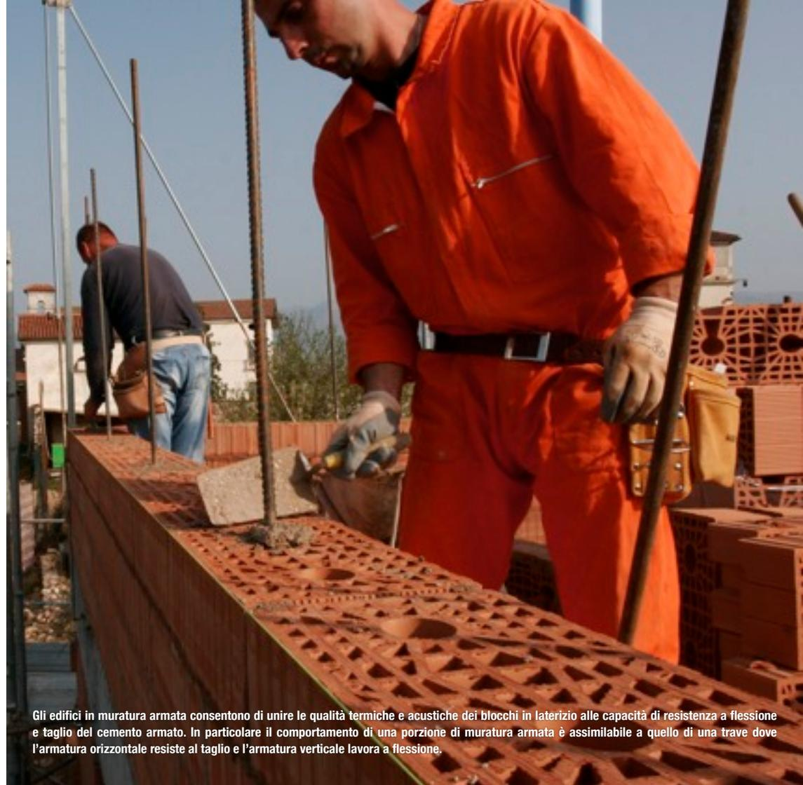
Gli edifici in muratura armata consentono di unire le qualità termiche e acustiche dei blocchi in laterizio alle capacità di resistenza a flessione e taglio del cemento armato. In particolare il comportamento di una porzione di muratura armata è assimilabile a quello di una trave dove l'armatura orizzontale resiste al taglio e l'armatura verticale lavora a flessione.
