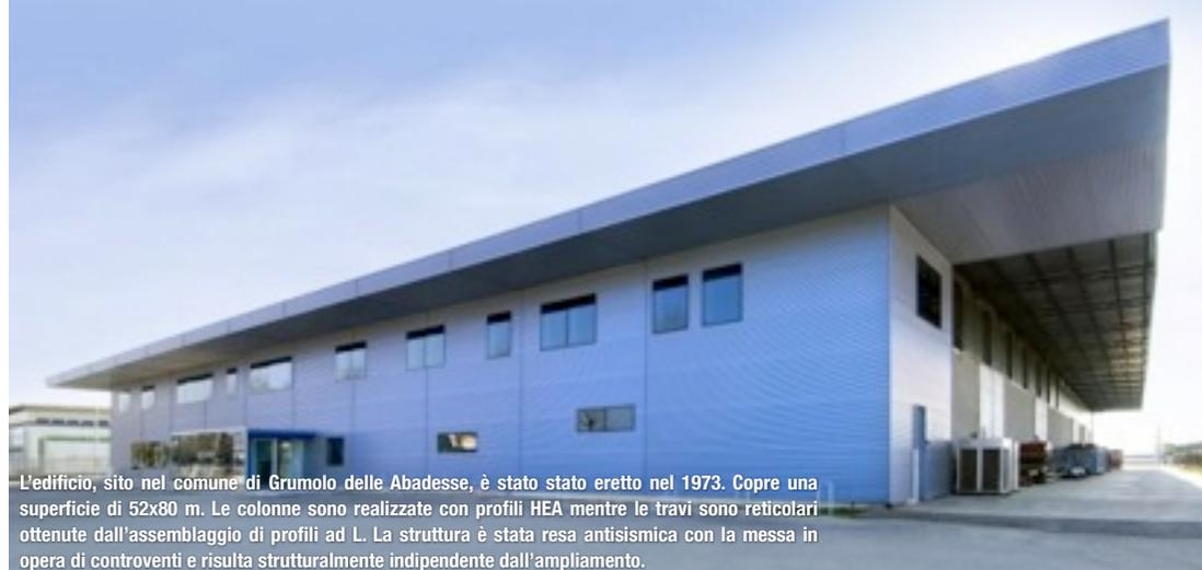
L'edificio, sito nel comune di Grumolo delle Abadesse, è stato eretto nel 1973. Copre una superficie di 52x80 m. Le colonne sono realizzate con profili HEA mentre le travi sono reticolari ottenute dall'assemblaggio di profili ad L. La struttura è stata resa antisismica con la messa in opera di controventi e risulta strutturalmente indipendente dall'ampliamento.
